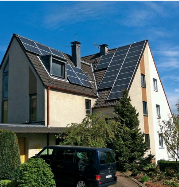
Eine Fotovoltaikanlage liefert heute genügend Strom für ein Einfamilienhaus
