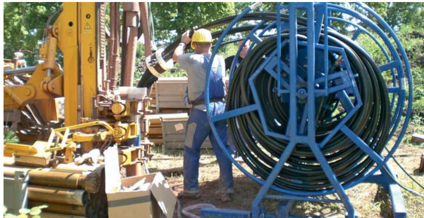
Einbau einer Erdwärmesonde
