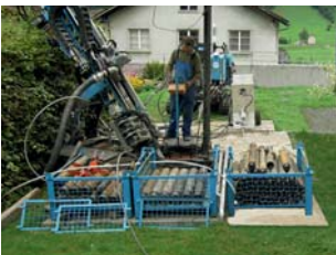
Durchführung einer Erdwärmesondenbohrung in Kreuztal und in der Schweiz
